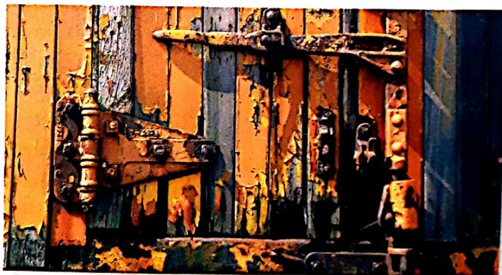
Fig. 10-11. Corrosión en bisagras de hierro de una puerta antigua.
